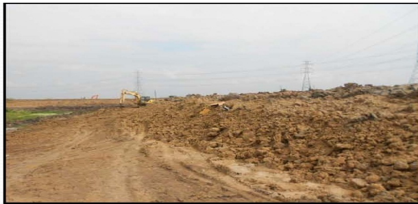
Fill Embankment & compact El.+ 2.90 m.
